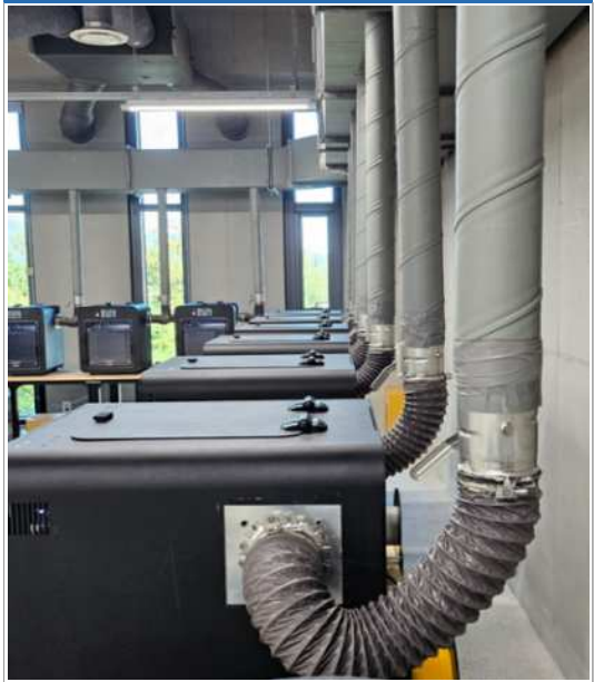
④ 3D 프린터 개별 환기설비 설치
