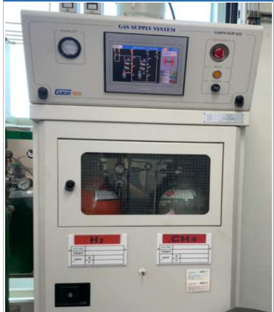
④ 실내 고압가스(가연성) 실린더 케비넷 설치
